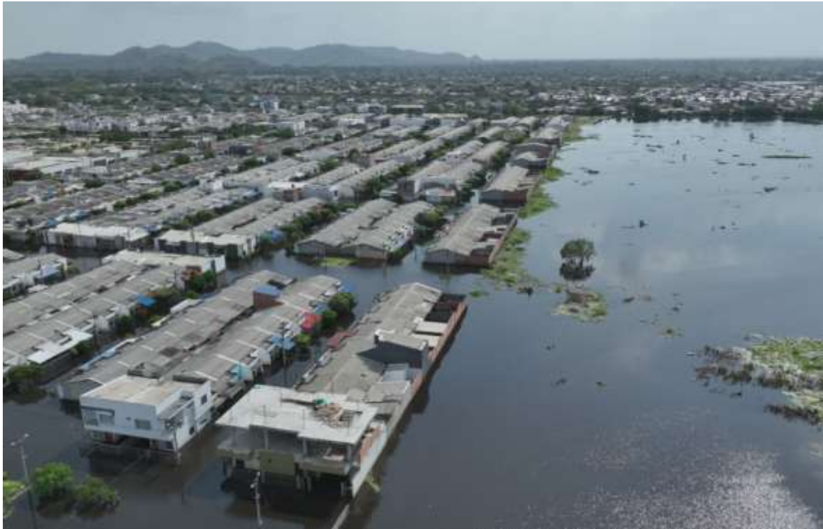
Figura 8. Viviendas inundadas en el barrio Vallejo 13 febrero 2026, Municipio de Montería, Córdoba. Fuente: 3iSolutions.
