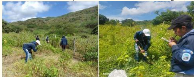
Gráfica 193. Adecuación del terreno para establecimiento del material vegetal, PNN Macuira
